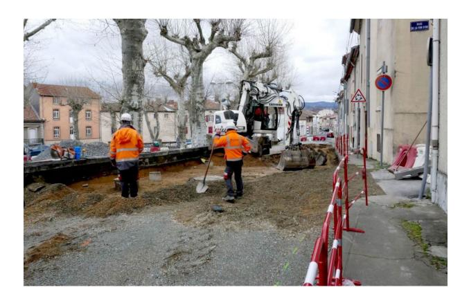
Préalablement à la réalisation des travaux de finition et suite au diagnostic géotechnique, le CD62 va décaisser la chaussée et procéder à la mise en place d'une nouvelle couche de forme en GNT + intervenir en entretien sur les 3 Ouvrages d'Art
